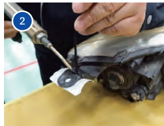
2 トーチで加熱し窒素でガスシールドを行いながら溶接棒を溶かし込む
