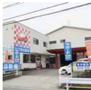
BPセンター外観
